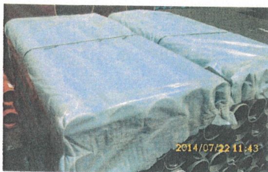
Način pokrivanja cevi u vremenu pojačanog UV zračenja
